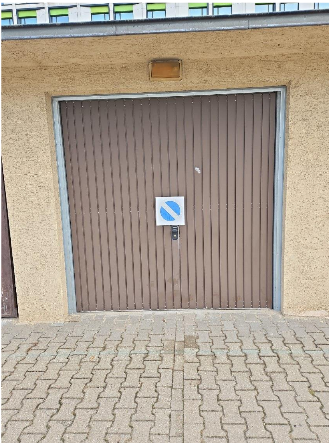
Zdjęcie 1. Garaż od frontu, zlokalizowany w środku ciągu budynków G. Powierzchnia ok. 20 m 2 .
